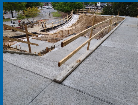
Pour ADA Ramp, Sidewalks, and Exterior Stairs
